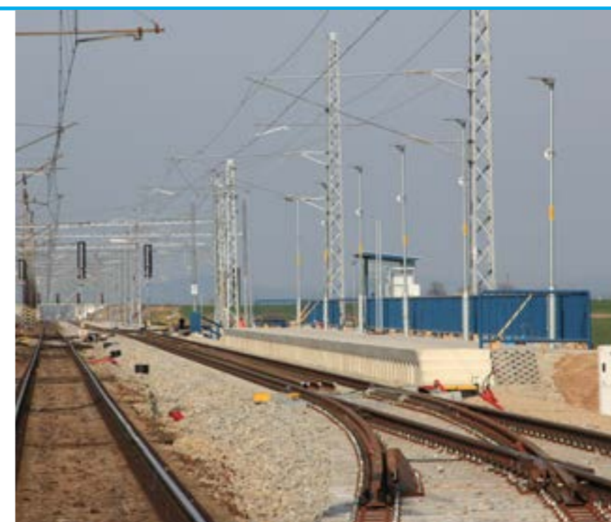
Práce na zastávce v Dyníně.
