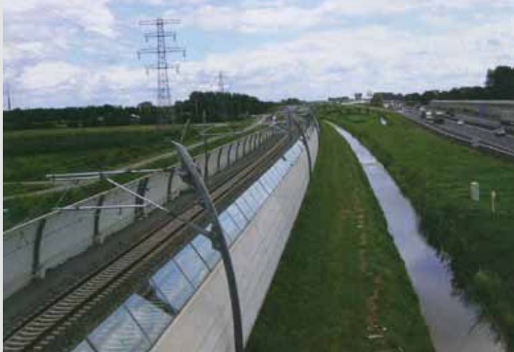
▲ Obr. 4. Železniční koridor z Rotterdamu do Německa, podél dálnice A15. Použity jsou zakřivené betonové panely doplněné v horní části transparentním materiálem [3] Řešení této protihlukové stěny je zajímavé z estetického hlediska avšak o její funkčnosti by se vzhledem k blízkosti dálnice, dalo pochybovat.
