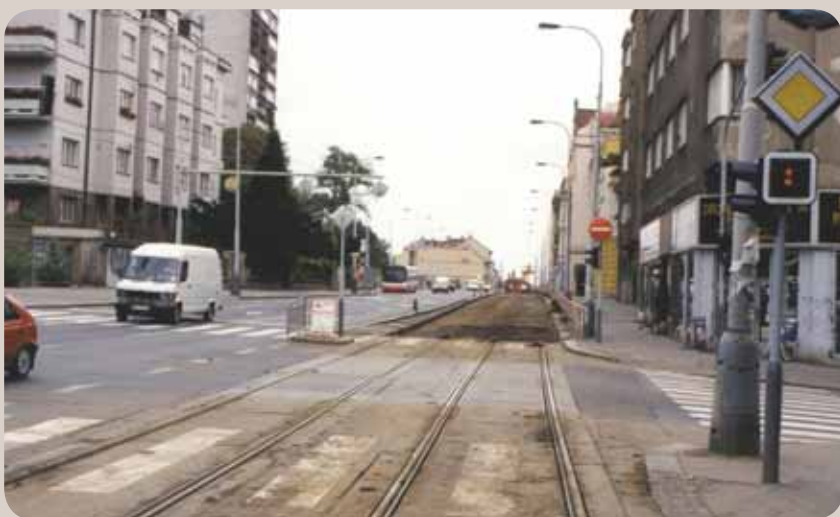
Od Klamovky směrem ke Zvonu probíhala souvislá výměna svršku BKV panelů v roce 2000.
