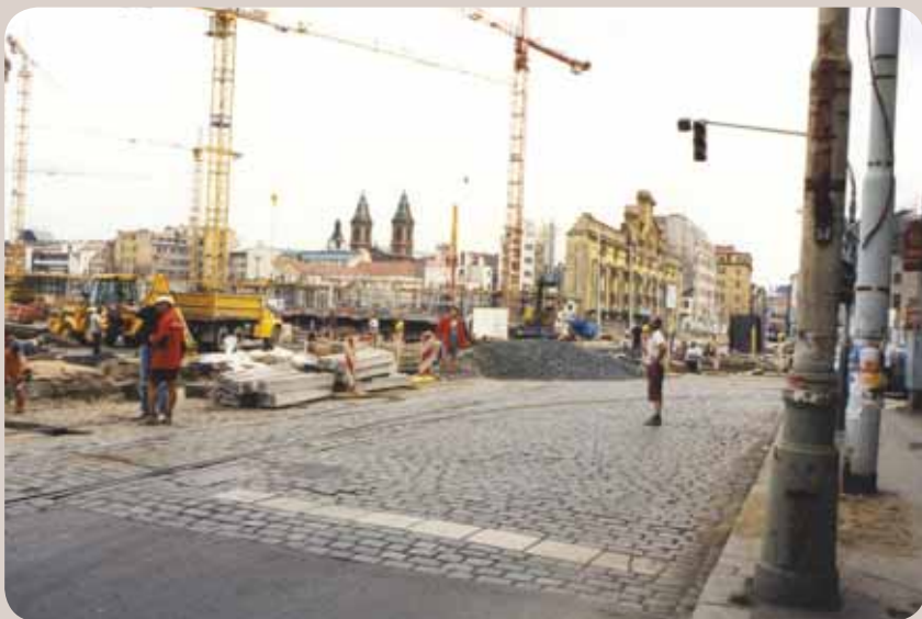
Křižovatka Plzeňská – Radlická před deseti lety byla jedno velké staveniště.
