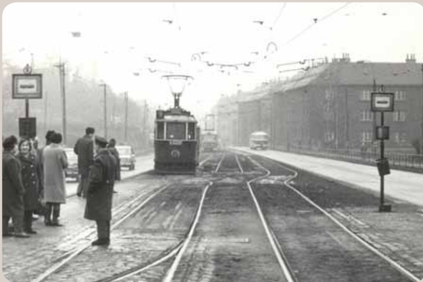
O třetí koleji na Kotlářce se v literatuře píše běžně, ale že byla provedena takto a všechny tramvaje musely jezdit odbočkou, vidíme až ze snímku Jiřího Čermáka fotografovaného 28. prosince 1973.
