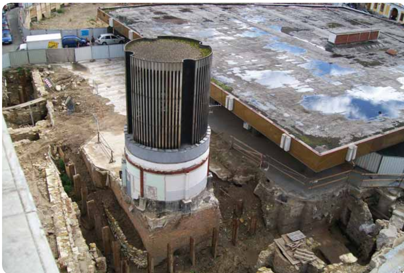
Pohled na stavební jámu pro COPA centrum.
