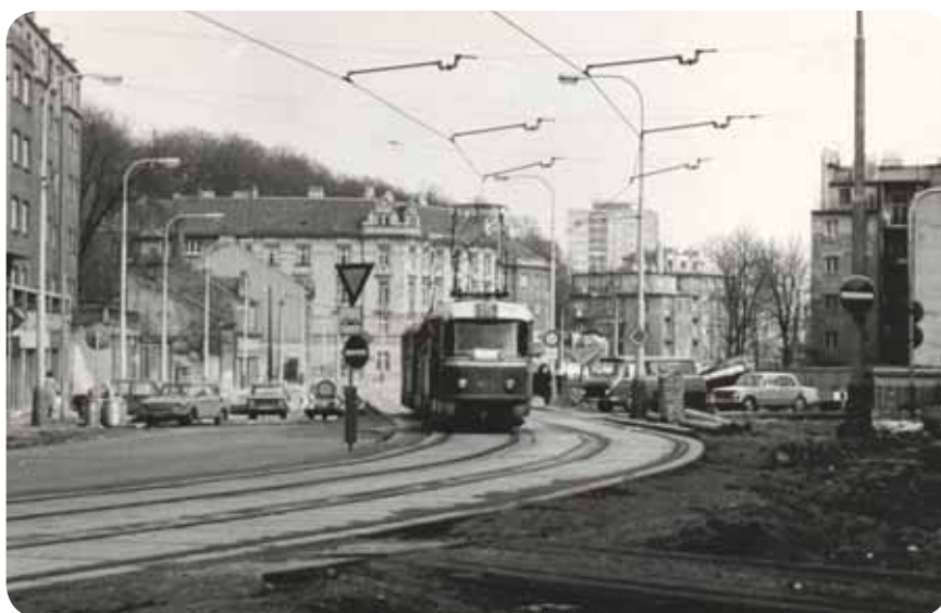
Namáhání oblouku v rozštěpu Plzeňské a Vrchlického ulice BKV panely nikdy dobře nezvládaly. Už 6. března 1980 byl takto ošklivě rozlámáný.
