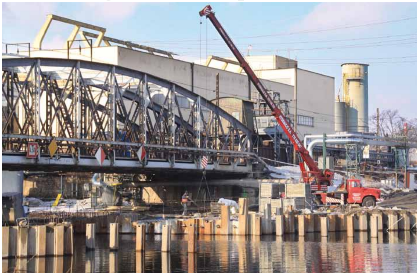
PŘÍPRAVY V MRAZECH. Zaměstnanci zakládání staveb připravují demontáž první části mostní konstrukce.
