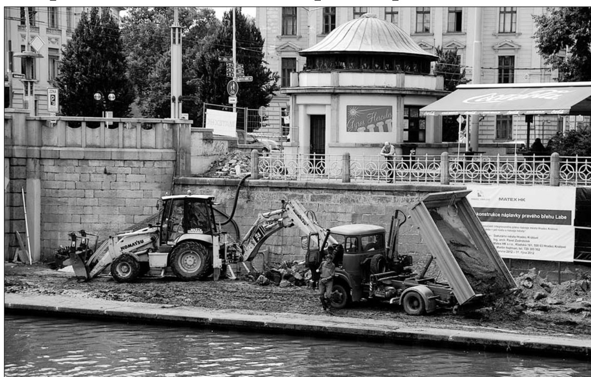
Do konce října by měla trvat v červnu zahájená rekonstrukce náplavky pravého břehu Labe mezi Tyršovým mostem a Hučákem. Práce, které mají prostor lépe zpřístupnit veřejnosti, zahrnou kompletní úpravu plochy včetně vydláždění a instalace osvětlení i laviček. Hlavní vstup na náplavku vzniká u Pražského mostu, kde odborná firma kromě jiného staví schodiště. Foto: Martin ČERNÝ
