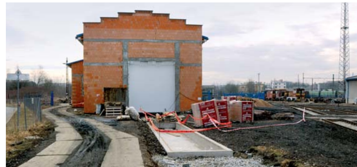
Na tomto místě bude zanedlouho stát kolejová váha s obrysníky. V objektu bude nová mycí linka.
