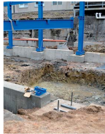
Příprava pro speciálně odpružený základ
