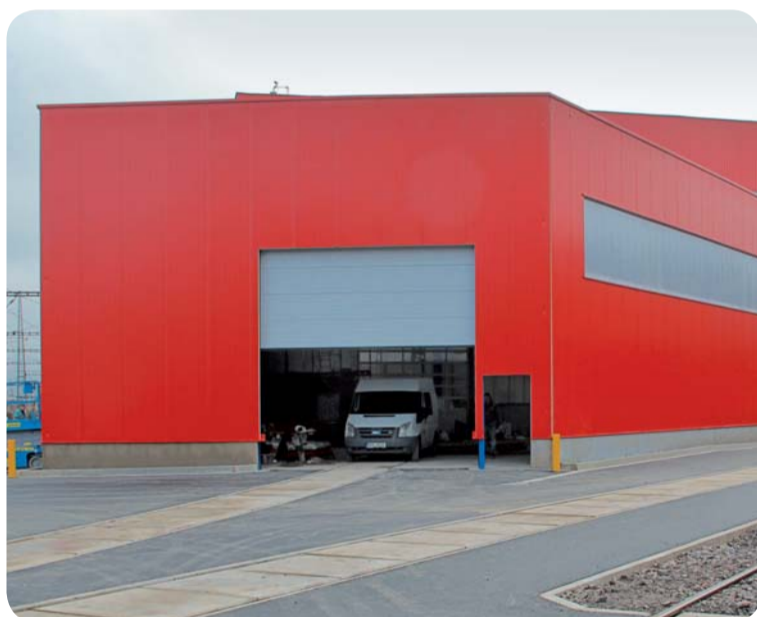
Sklad na počátku prosince, těsně před dokončením.
