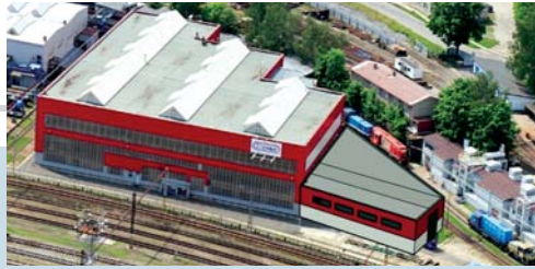
Největší letošní investicí je přestavba motorárny. Začne stavbou skladu
