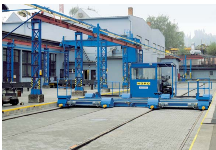
Během celozávodní dovolené došlo k výměně malé přesuvny lokomotiv
